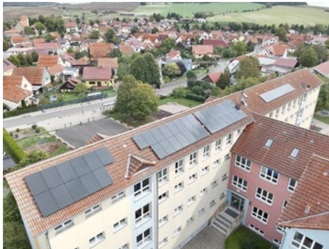
Vier neue Photovoltaikanlagen hat der Landkreis Schmalkalden-Meiningen allein in diesem Jahr auf kreiseigenen Dächern in Betrieb genommen – so auch am Thüringischen Rhön-Gymnasium in Kaltensundheim. Foto: BSH - Bestes.Solar.Handwerk
