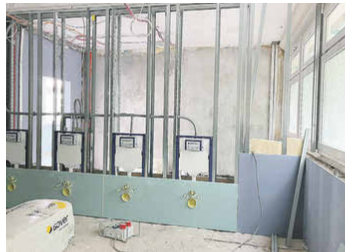
Wie in zahlreichen anderen Schulen wurde auch im Henfling-Gymnasium in Meiningen während der Sommerferien gebaut. Der Landkreis investiert hier in die Sanierung der WC-Anlagen sowie den Einbau eines barrierefreien WCs.
