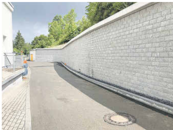
Nach 14 Monaten Bauzeit wurde die neue Stützmauer an der Zufahrt zum BBZ Meiningen unterhalb des „Drachenberg“ durch das Landratsamt Schmalkalden-Meiningen feierlich fertiggestellt und übergeben.
