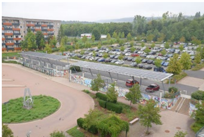
Hier ist man mit einem E-Auto gut aufgehoben: Auf dem Parkplatz am Meininger Landratsamt entstand ein neuer Carport mit PV-Anlage. Seit 2020 sind hier zudem zwei Ladesäulen der Stadtwerke Meiningen in Betrieb.
