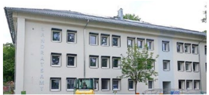
Ab 7. Oktober neu in der Charlottenstraße 5a in Meiningen: Die Fahrerlaubnisbehörde und die Kfz-Zulassung ziehen von Meiningen-Dreißigacker ins Zentrum der Kreisstadt. Aktuell stehen noch Restarbeiten im Außenbereich aus.
