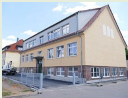
Die Generalsanierung der Grundschule Benshausen ist nach zweijähriger Bauzeit abgeschlossen.
