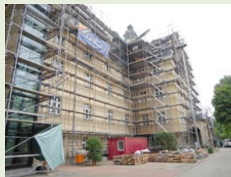
Während zahlreiche Bauprojekte mit Schulbeginn abgeschlossen wurden, läuft die millionenschwere Sanierung der Meiningener Pulverrasenschule nach den Sommerferien planmäßig weiter.
