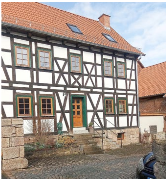
Für die Sanierung ihres Fachwerkhauses mit Scheune in Rohr, erhielten Martina und Matthias Blatt den Denkmalpreis des Landkreises 2019. Foto: Privat
