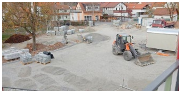
In der Grundschule Vachdorf gestalten Bauarbeiter derzeit die Außenanlagen.
