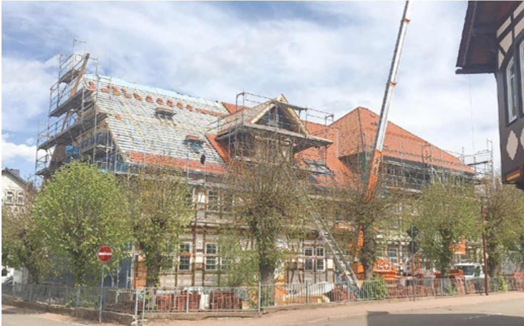
Eines der Großprojekte: Die Sanierung der Grundschule Brotterode ist ebenfalls bereits wieder angelaufen.
