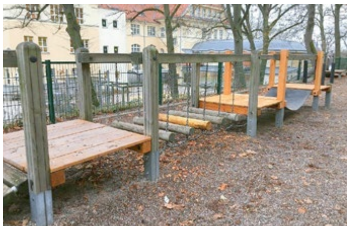
Bis Ende April wurden die Spielgeräte in der Grundschule Schmalkalden erneuert. Die Reparatur der Balancierstrecke ist bereits abgeschlossen.
