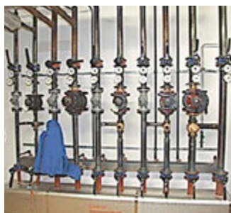
Energetische Sanierungsmaßnahmen im Bestand am Beispiel des Rhön-Gymnasiums in Kaltensundheim: Dämmung der Anlagentechnik
