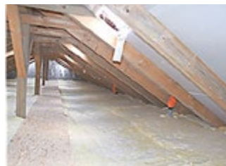
Energetische Sanierungsmaßnahmen im Bestand am Beispiel des Rhön-Gymnasiums in Kaltensundheim: Aufbringung einer Wärmedämmung auf die oberste Geschossdecke.
