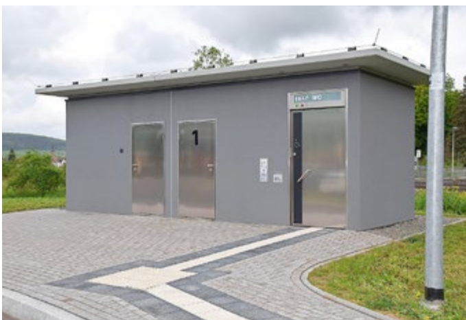
Von vielen Fahrgästen gewünscht: Eine behindertengerechte WC-Anlage.
