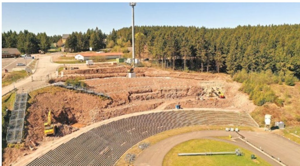
Die Baumaßnahmen an der Tribüne und der Biathlon-Arena in Oberhof sind in vollem Gange.
