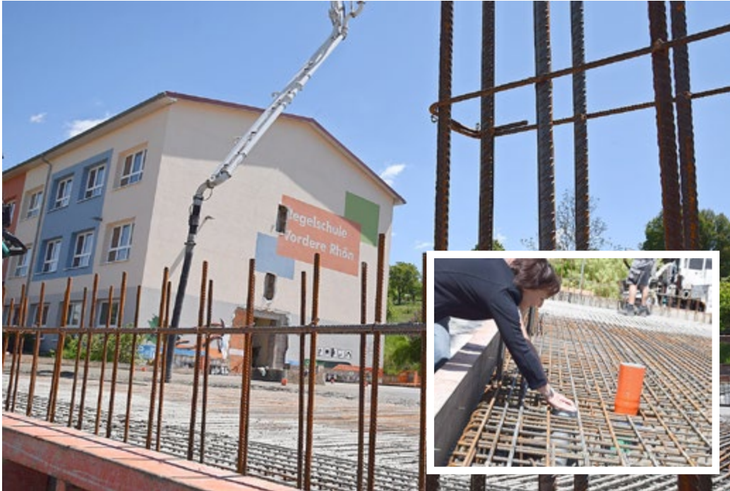
Die Sanierung der Staatlichen Regelschule „Vordere Rhön“ in Bettenhausen ist eines der derzeit größten Schulbauvorhaben im Landkreis.
