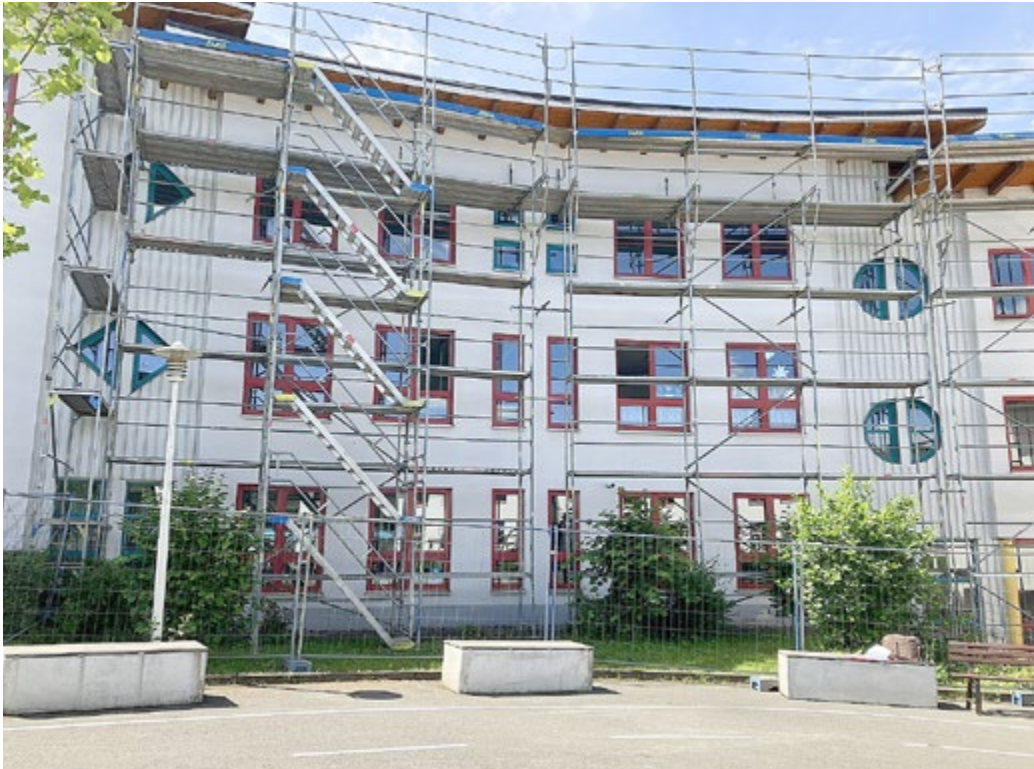
Im Regionalen Förderzentrum Schmalkalden wird eine Teildachfläche saniert.
