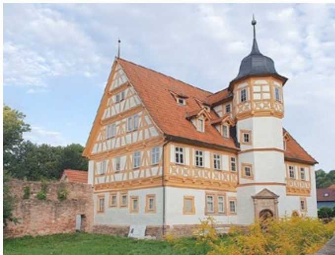
Nach der Fassaden-Sanierung ist das 1596 erbaute Damenstift in Wasungen ein echter Hingucker. Bernhard Marschalk von Ostheim ließ das Haus 1596 für adelige Damen errichten.
