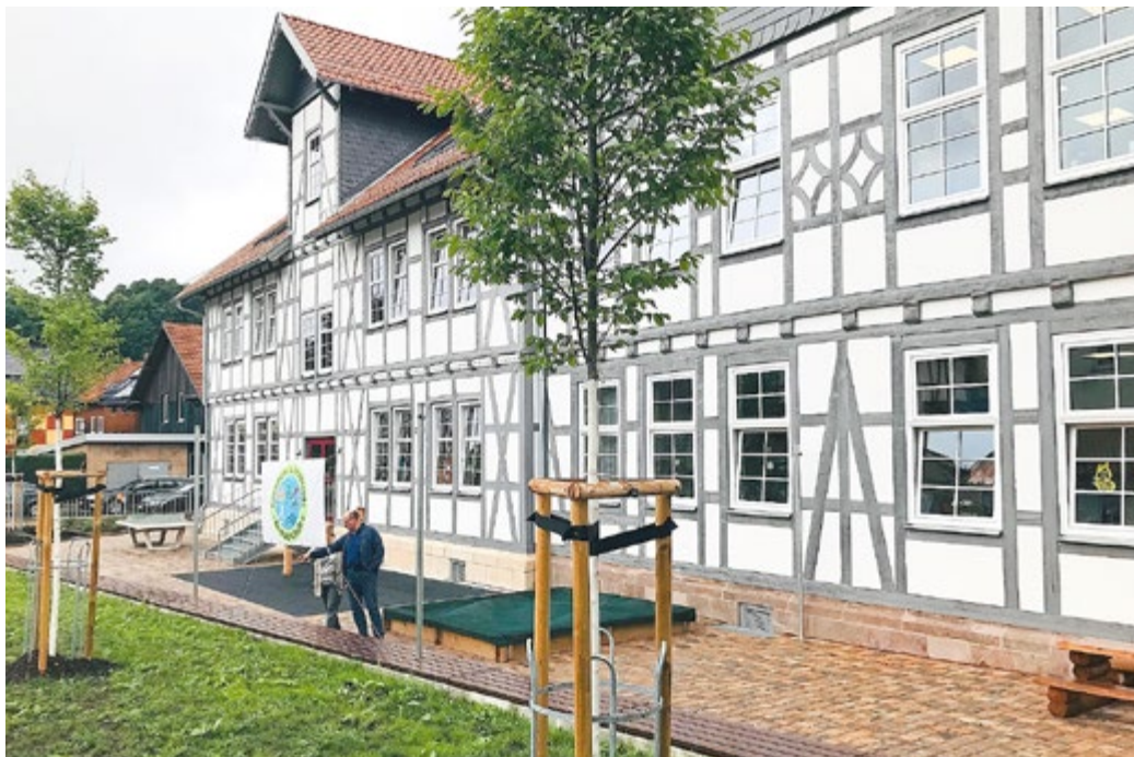
Historischer Charme trifft moderne Optik: Die Fachwerk-Fassade der Grundschule Brotterode wurde denkmalgerecht zu einem absoluten Blickfang saniert.
