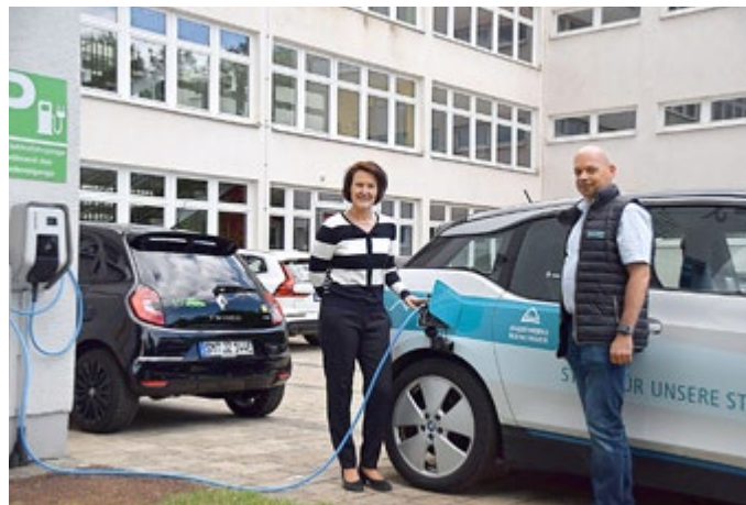
Landrätin Peggy Greiser und Thomas Zingel (Bereichsleiter Technik der Stadtwerke Meiningen GmbH) nehmen die beiden neuen Wallboxen für E-Autos am Henfling-Gymnasiums in Betrieb.
