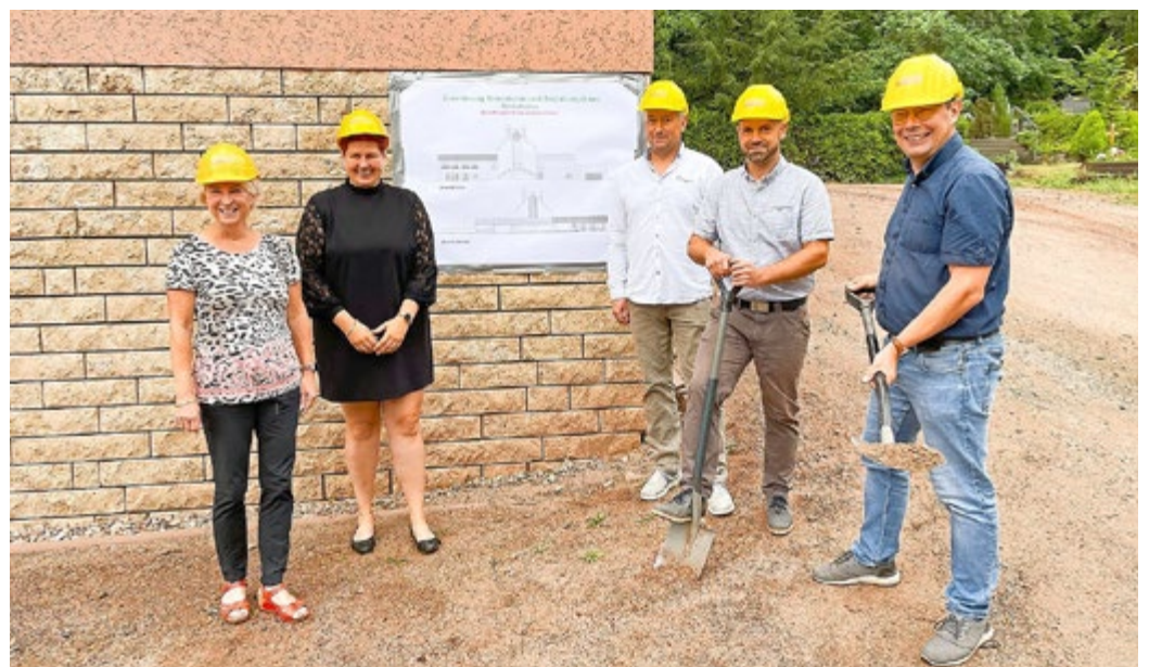
Startschuss für die lang ersehnten Bauarbeiten: Bürgermeister Thomas Kaminski setzte zusammen mit Prokurist der Bestattungen Schmalkalden GmbH René Kindler, dem Leiter des Krematoriums Heiko Höckendorf, der Leiterin Bestattungen Nancy Eger und der Bauleiterin von der Henkel-Bau GmbH, Elke Ziegler, den ersten Spatenstich.
