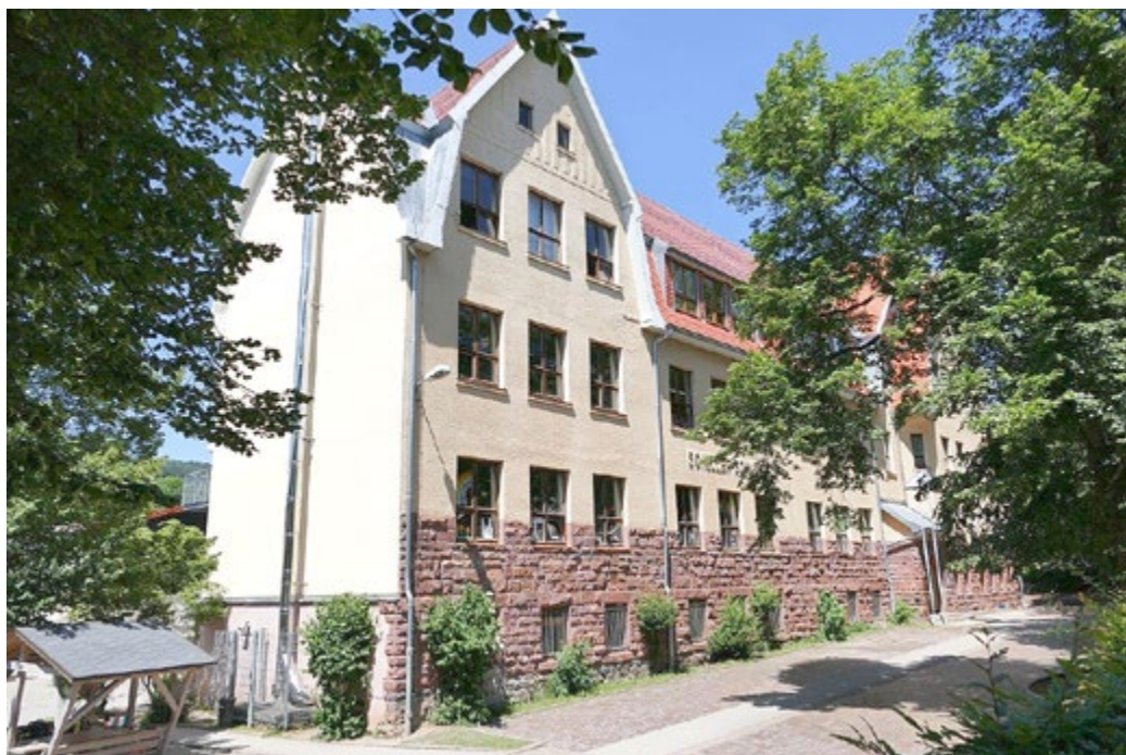
Die Grundschule Friedrich-Schiller in Zella-Mehlis konnte 2019 die höchsten Energieeinsparungen verbuchen.
