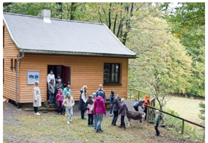
Schmuck sieht die sanierte Hütte jetzt aus.
