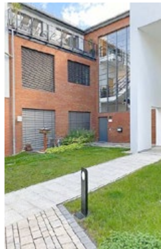
LutherLoft / Gebäude B – Treppenhaus nach Rekonstruktion Foto: [VierRaum]
