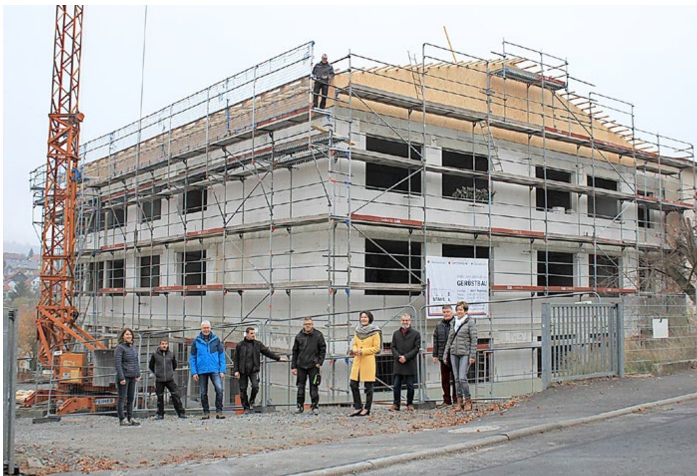
Das klein gehaltene Richtfest begangen gemeinsam Landrätin Peggy Greiser (4.v.r.), Schulleiter Klaus-Peter Weisheit (3.v.r.), der Fachdienstleiter Bau- und Gebäudeverwaltung im Landratsamt Günter Roth (3.v.l.), Sandra Schilling (l.), die das Projekt im Landratsamt betreut, die bauleitende Architektin Jutta Knipping und Geschäftsführer Lorenz Koch von der Firma Esko-Bau (r.) sowie einige Bauleute.
