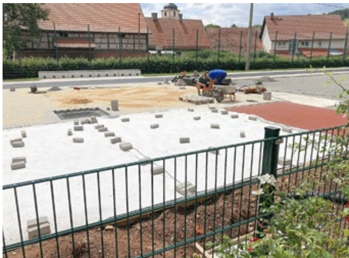
An der Grundschule Herpf nimmt die neue Außensportfläche zunehmend Gestalt an.
