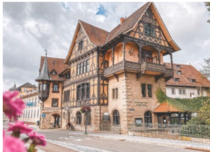
Eines von vielen Vorbildern für den Erhalt alter Baukultur: Das Henneberger Haus in Meiningen ist ein markanter, unter Denkmalschutz stehender Fachwerkbau von 1894/95 und ein Wahrzeichen der ehemaligen Residenzstadt. Foto: Good Morning World
