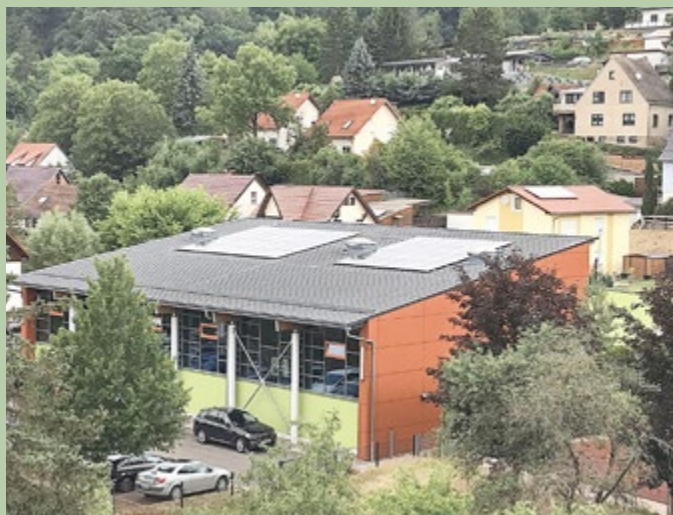
Auf dem Dach der Sporthalle Wasungen kann nun eine PV-Anlage mit einer Leistung von 23,5 kWp genutzt werden.
