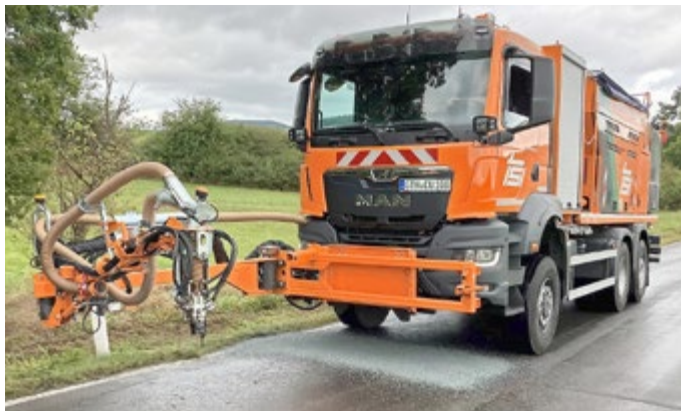
Mit neuester Technik im Einsatz: Ein Spezialfahrzeug der Thüringer Straßeninstandhaltung aus Walldorf sprüht Asphaltmischung in Schlaglöcher und Unebenheiten – so wird das Kreisstraßennetz fit für den Winter gemacht.
