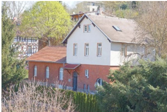
Blick auf das Stadt- und Kreisarchiv Schmalkalden am Schlossküchenweg 15: Der langgestreckte Teil des Gebäudes diente bis in die 1950er Jahre als Maschinensaal des Wasserwerkes. Im Wohnhaus daneben befand sich die Verwaltung und eine Wohnung. 1974 wurden die Archive der Stadt und des Kreises Schmalkalden hier untergebracht und bildeten nun ein Territorialarchiv.
