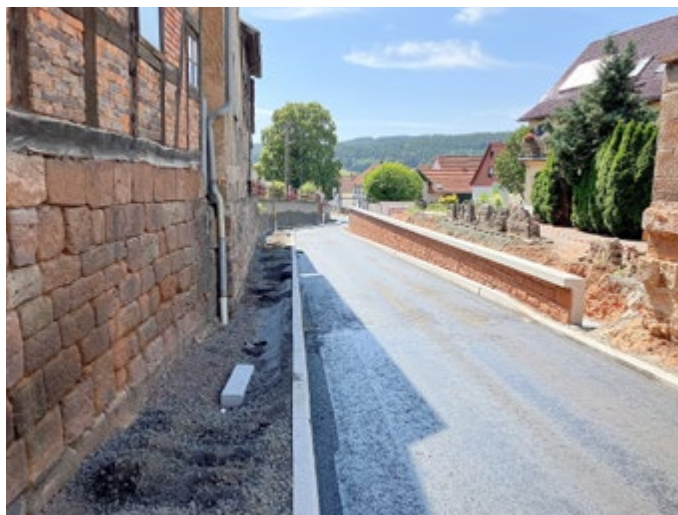
Neue Stützwand in der Eisenacher Straße in Schwallungen: Sie sichert den Straßenbereich und ermöglicht den weiteren Ausbau.
